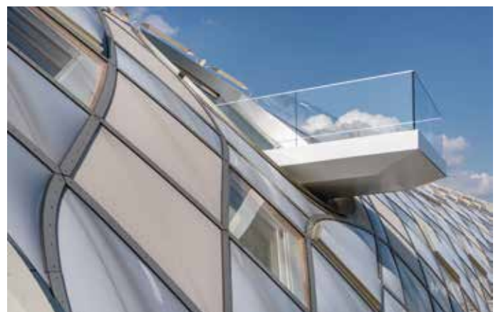
Die Tausenden Holzwablen in Biel dienen als Fenster, Verschattung oder PV-Zelle
